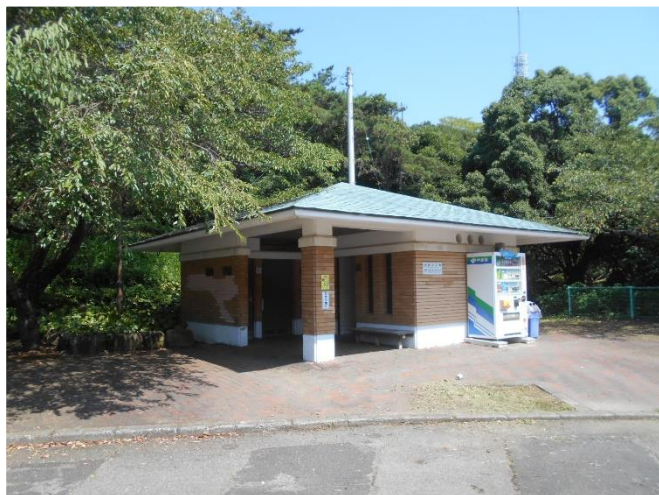
駐車場トイレ
