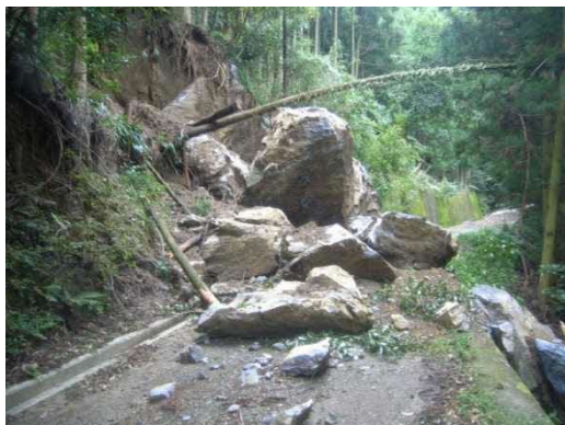
斜面崩壊の状況（平成 28 年 9 月） 飯谷町
