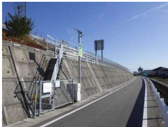
加賀須野津波緊急避難施設 （川内町大松）
