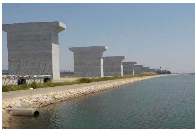
整備中の四国横断自動車道 沖洲付近
