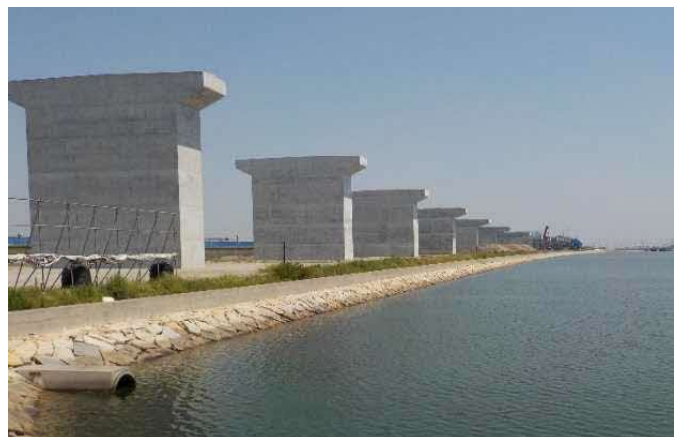
整備中の四国横断自動車道 沖洲付近
