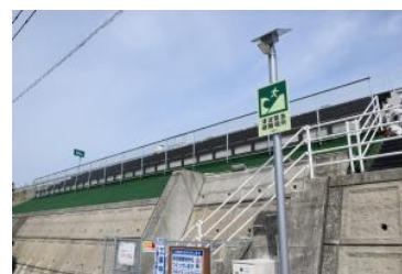
津波避難施設
