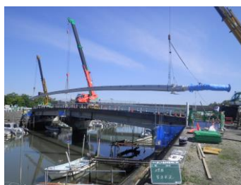
橋りょう添架管架替工事
