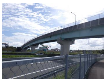
橋りょうの耐震補強
