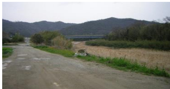
【園瀬川】川西地区・明善地区の堤防整備及び上中筋地区の漏水対策の促進
