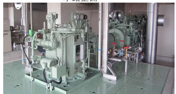
ポンプ場施設整備
