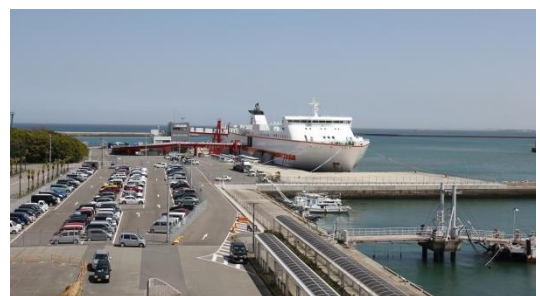
徳島小松島港沖洲（外）地区 複合一貫輸送ターミナル
