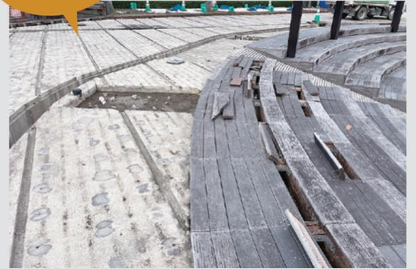
新しい木材を使わず、既存のデッキ材を研磨して再利用する工法により、しんまちボードウォークのリニューアル工事を行っています。従来工法と比較して、約130トンのCO<sub>2</sub>排出量削減が見込まれます。
