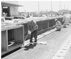
水害に備えて樋門を点検
