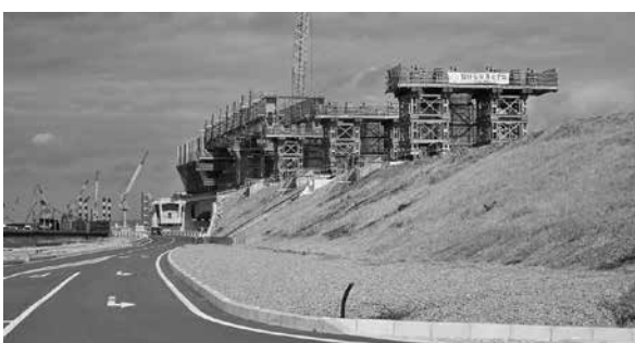
高速道路工事
