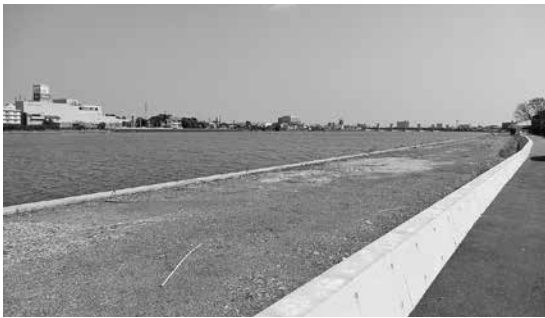
護岸工事が進んでいる現在の今切川（古川）
