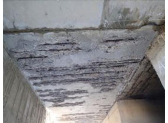
RC床版下面面に浮き、剥離・鉄筋露出
