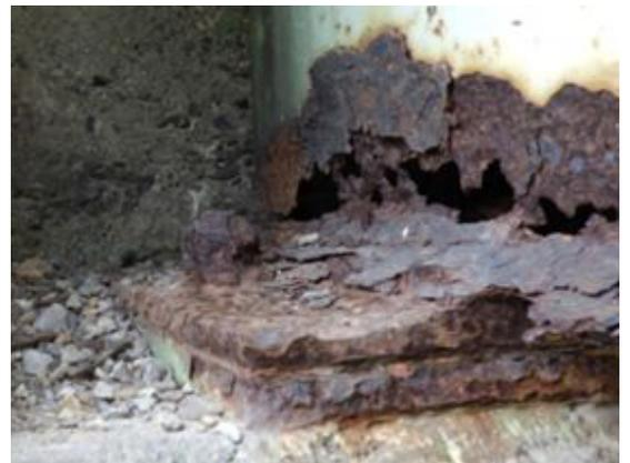
H桁橋の桁端部及び支承の腐食
