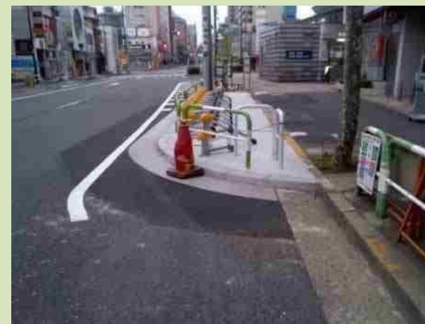
東京都豊島区新大塚駅周辺における歩道を一部拡幅しての駐輪施設設置例 【出典：自転車等駐車場の整備のあり方に関するガイドライン】
