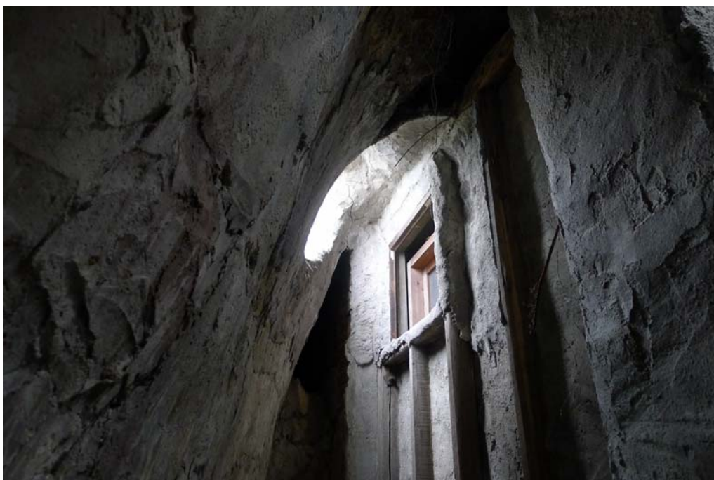
273 内部背面側、個室(南)外
