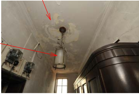
137 2階東側廊下 天井
