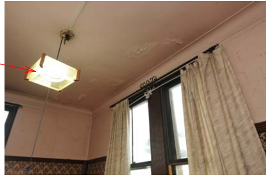
160 2階応接室 天井
