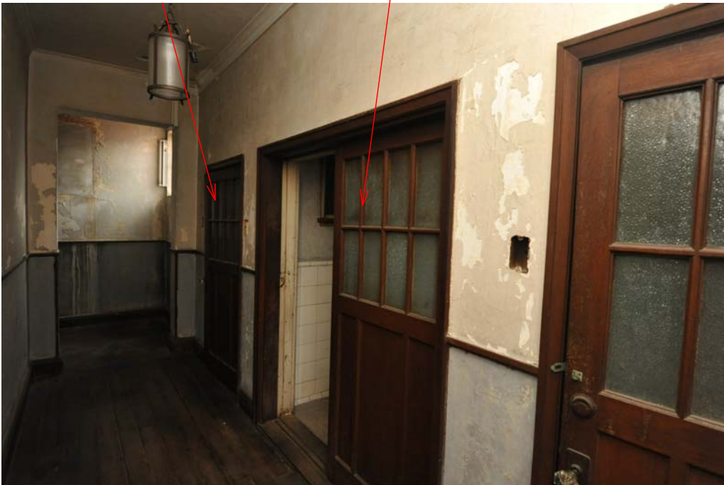
136 2階南側廊下 南面
