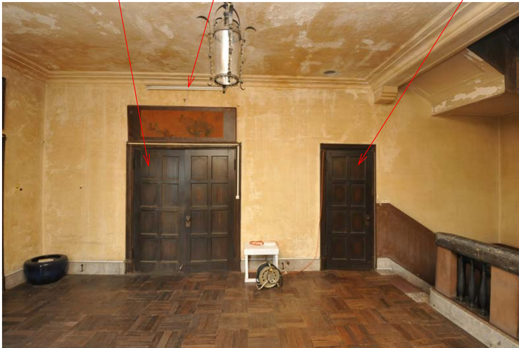
104 2階廣間階段室 東面
