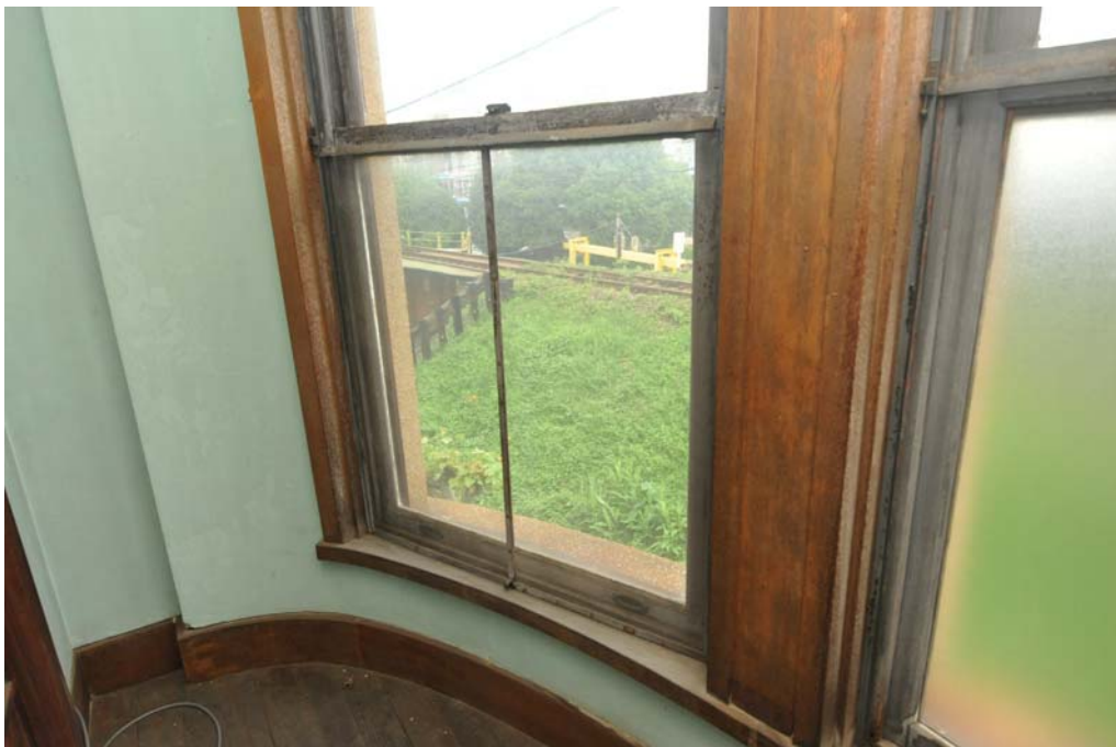
126 2階夫人室縁側 上下窓
