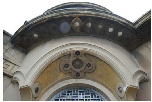
092 2階バランダ 軒飾り 見上げ
