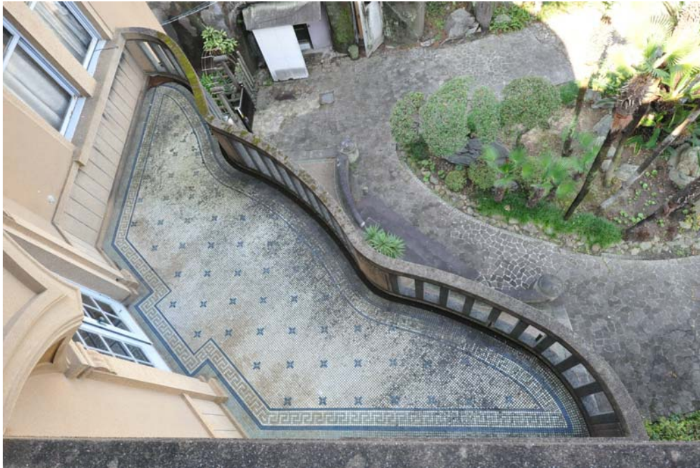
093 2階バランダ 床タイル
