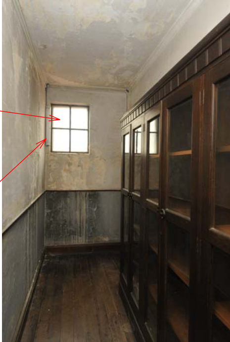
138 2階東側廊下 南向き
