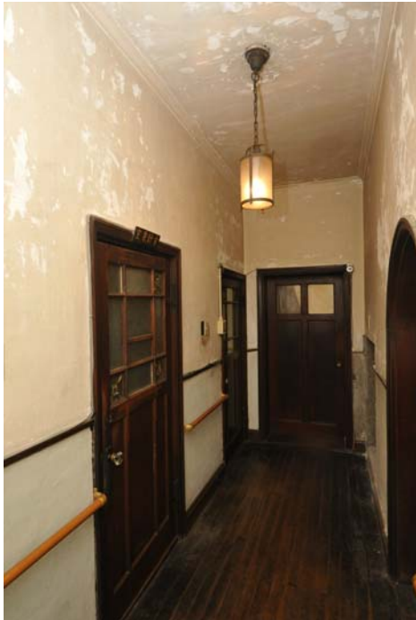
054 1階廊下 西向き 1
