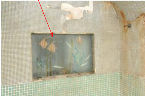
060 1階浴室 はめ殺し窓
