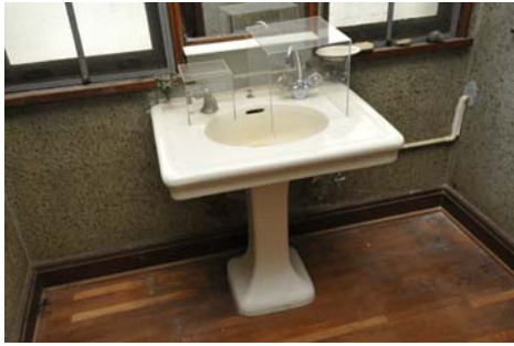
067 1階脱衣室化粧室 洗面台
