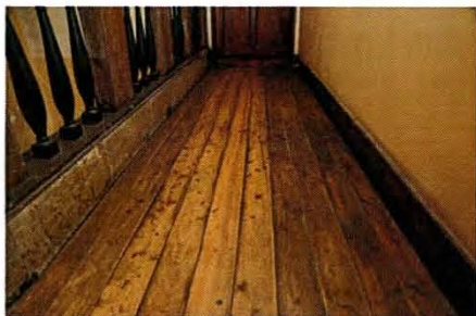
17 廊下床板の不陸 廊下床板に不陸を生じている。経年によるもの。
