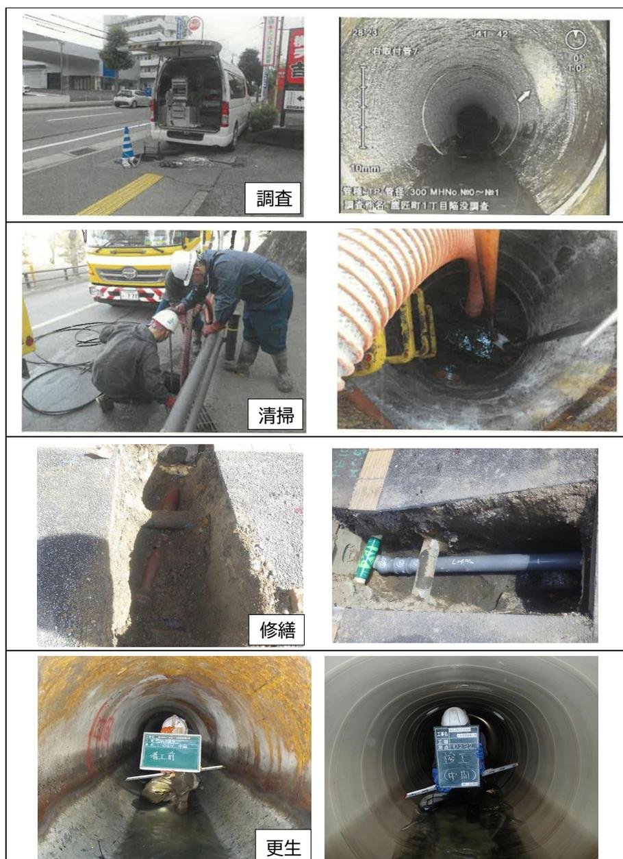
図 3-2 老朽管の調査・清掃・修繕・更生<sup>(※32)</sup>
