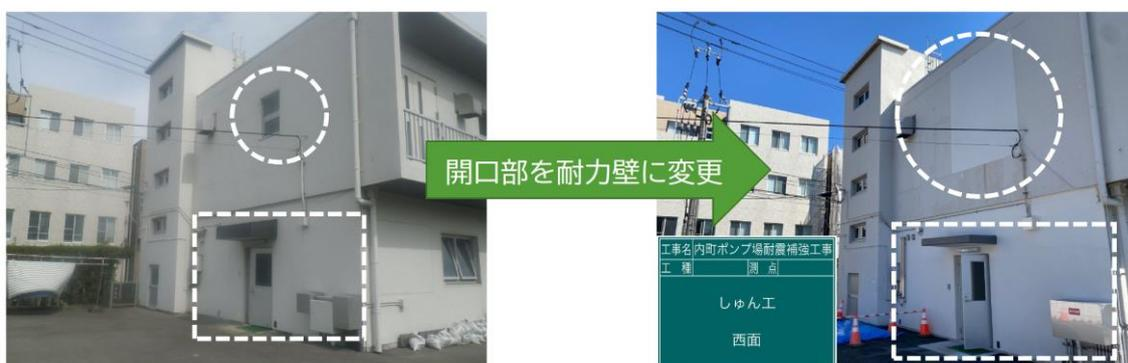
図 3-5 処理場・ポンプ場の耐震補強
