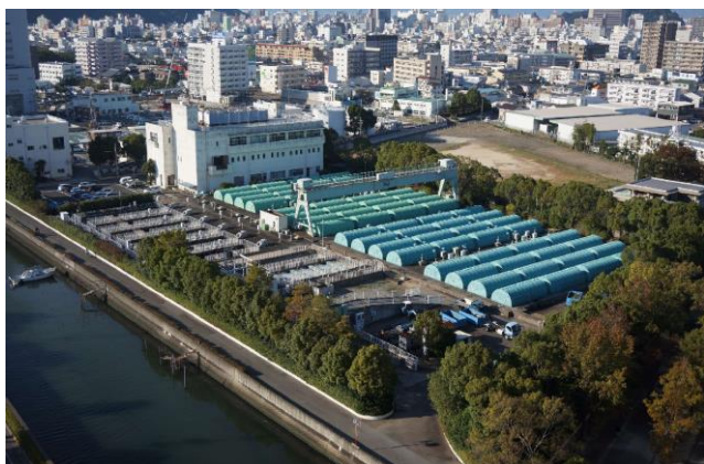
中央浄化センター
