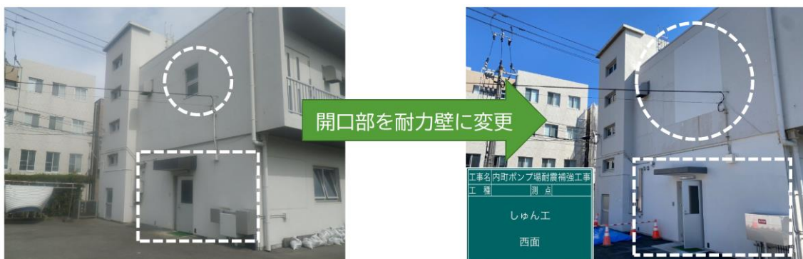
図 3-5 処理場・ポンプ場の耐震補強
