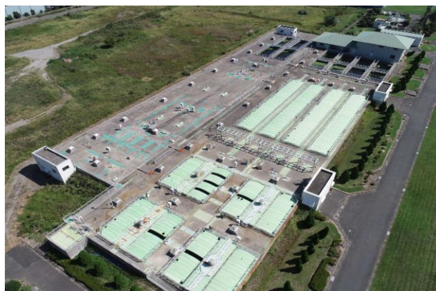
北部浄化センター
