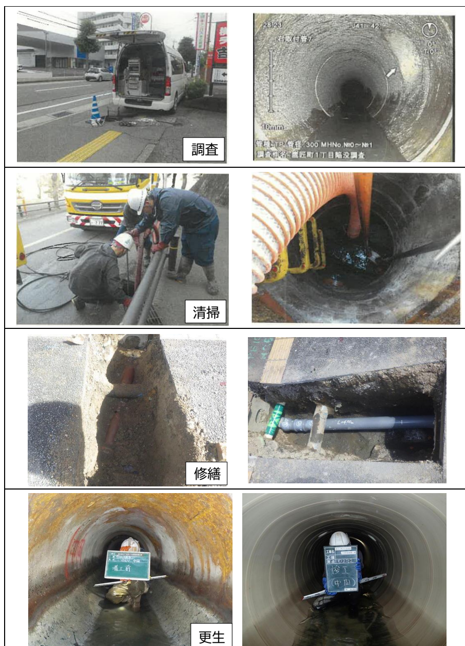
図 3-2 老朽管の調査・清掃・修繕・更生 (※32)
