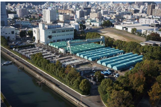
中央浄化センター
