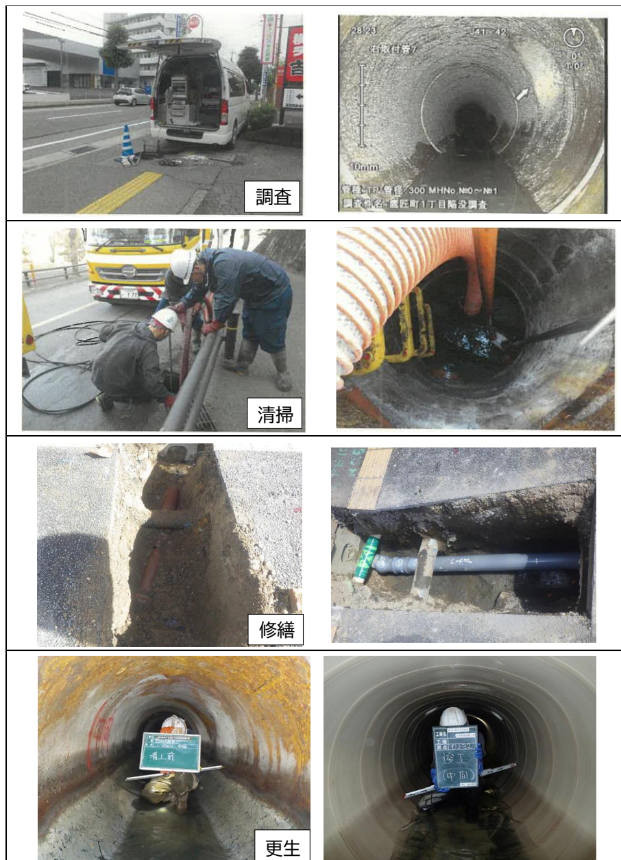
図 3-2 老朽管の調査・清掃・修繕・更生 (※32)
